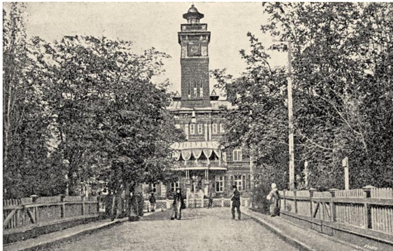
50 Главный фасад Николаевской городской больницы г. Ростова-на-Дону с пожарной каланчей, обращенный на ул. Большую Садовую. Нач. XX в.
