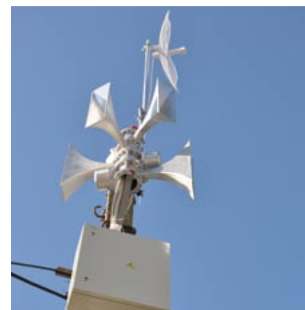
Рупорный громкоговоритель ГР-100, предназначенный для оповещения жителей при возникновении ЧС
