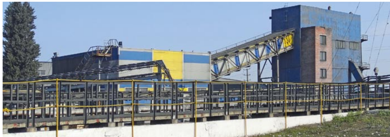
Промплощадка шахты «Шерловская-Наклонная»
