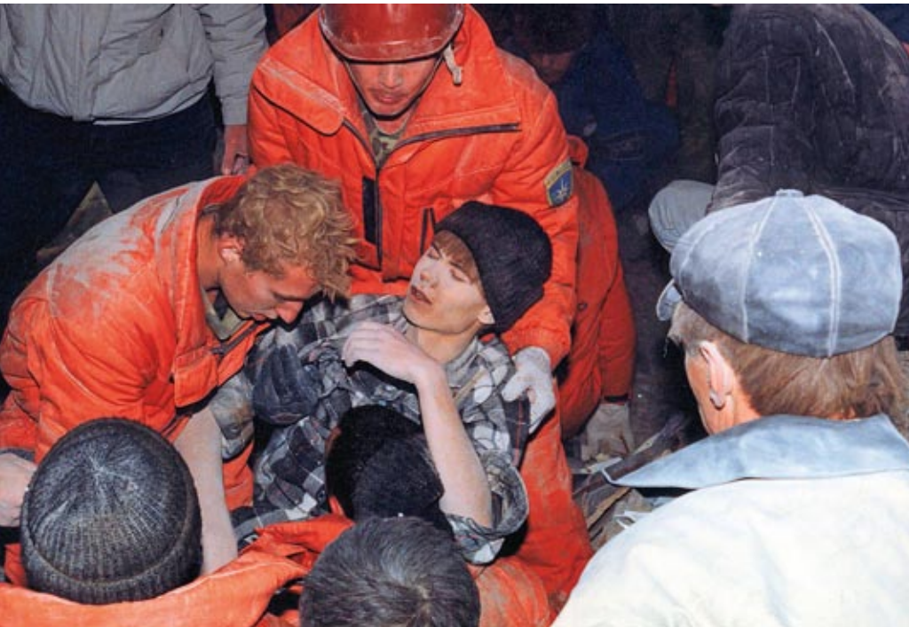
Ликвидация последствий обрушения несущих конструкций центральной части жилого дома в Зернограде 4 декабря 1999 г. 33-квартирный четырехэтажный дом на улице Социалистической эксплуатировался с 1964 г. Причиной трагедии стала потеря несущей способности продольной кирпичной стены в подвале дома из-за переувлажнения и нарушений технологий строительства. Под завалами погибло 11 человек, 4 были травмированы. В результате работы спасателей сохранена жизнь 79 человек.
