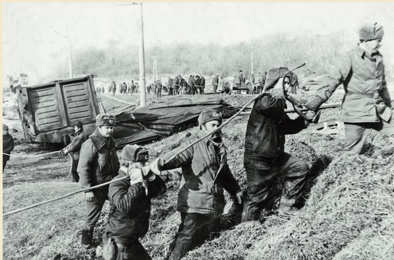
Батальон майора Олега Маслюка (1-й слева) ведет восстановительные работы в районе станции Спитак
