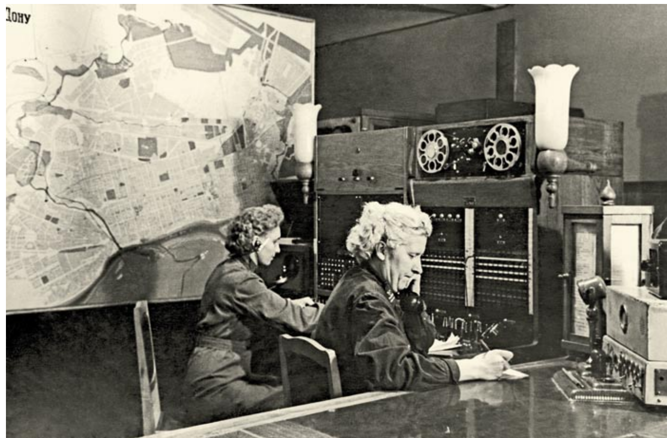
На центральном пункте пожарной связи. Ростов-на-Дону. 1950-е гг.
