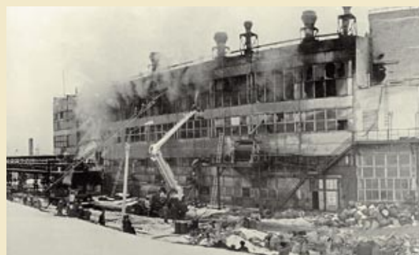
Тушение пожара в цехе лаков РХПО в Западной промзоне Ростова-на-Дону. 1980 г.
