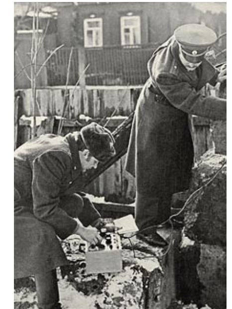
Исследование конструкции после пожара. 1980-е гг.
