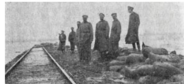
Укрепление мешками с песком и мусором железнодорожного пути со стороны прибоа волн донского разлива. 1917 г. Из книжного фонда Ростовского областного музея краеведения
