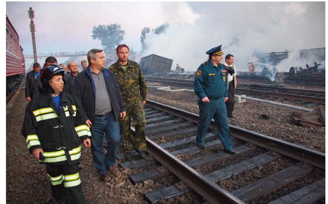
Губернатор Ростовской области В.Ю. Голубев контролирует ход восстановительных работ на станции Белая Калитва. Май 2013 г.
