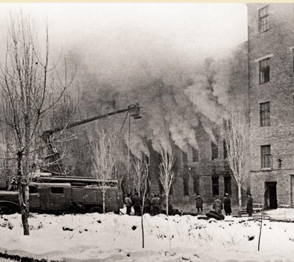
176 Пожар на складе обувной фабрики в городе Шахты. Декабрь 1967 г.
