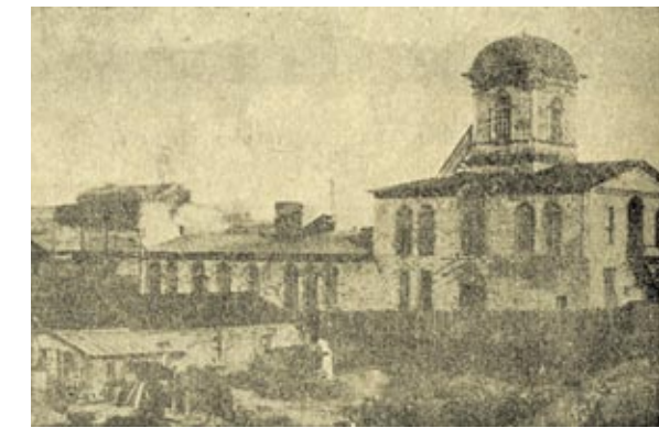
Каменное здание над шахтой Рыковских копей
