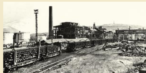
Восстановительные работы в районе станции Спитак
