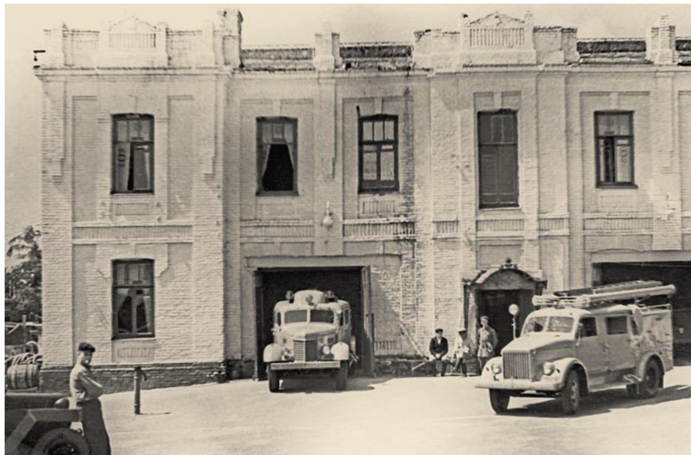
150 Здание 3-й пожарной части города Новочеркаска по ул. Пушкинской, 41. 1958 г.
