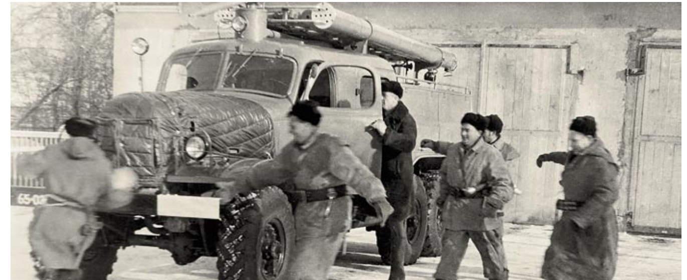
Выезд по тревоге на тушение пожара в жилом доме по ул. Чкалова в городе Зернограде. 1971 г.
