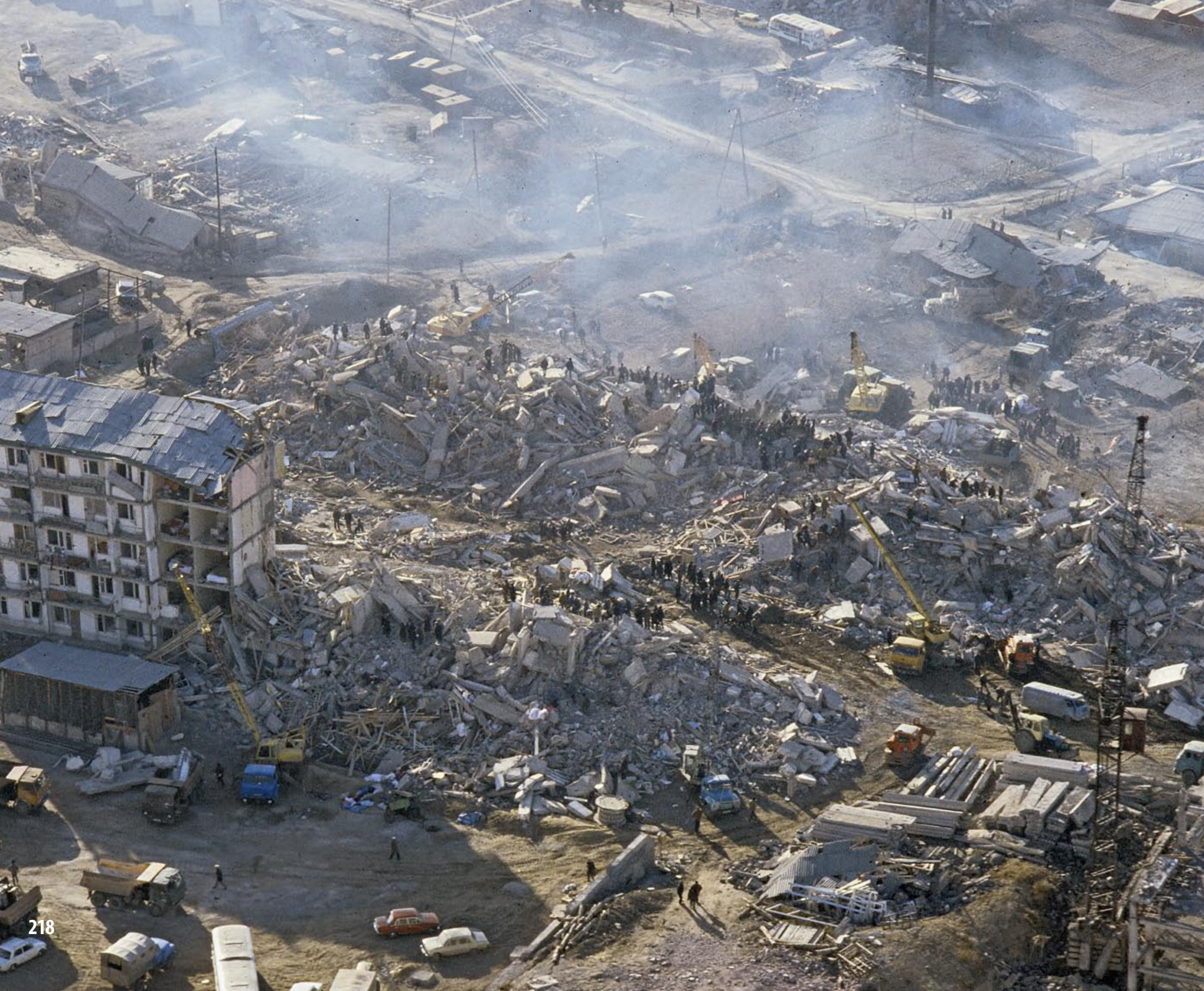
Последствия землетрясения 7 декабря 1988 г. в его эпицентре – городе Спитаке (Армения). 8 декабря 1988 г. Фото Александра Гращенкова, МИА «Россия сегодня»
