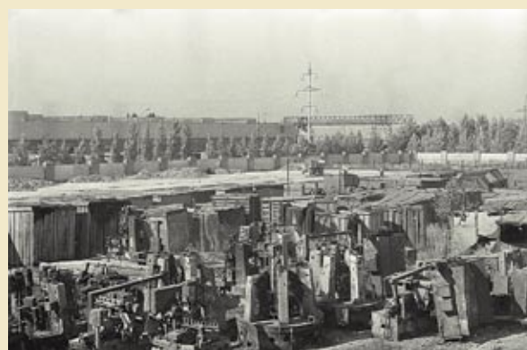
Последствия пожара на поршневом заводе в Ростове-на-Дону. 1981 г.
