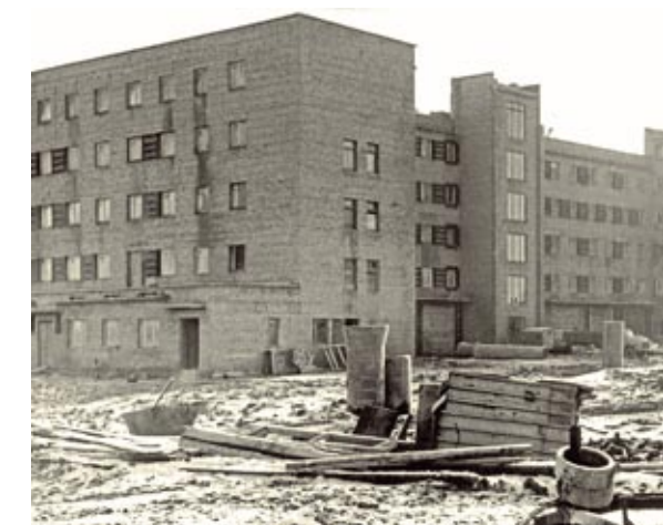
Строительство здания 17-й пожарной части в городе Волгодонске. С 1989 г. – Учебный центр Управления пожарной охраны Ростовской области. 1985 г.
