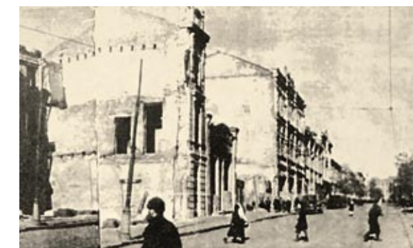
Послевоенный Ростов. Поврежденные огнем и сгоревшие здания по ул. Московской. 1945 г.
